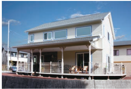
真冬でもエアコン1台で快適な環境を創造するM邸
